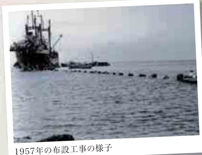
1957年の布設工事の様子
