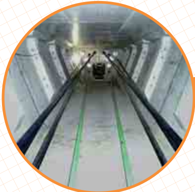
内部充てん型エポキシ樹脂被覆PCケーブルの橋梁桁内での設置状況 [写真提供: 三井住友建設(株)、場所: 交野高架橋]
