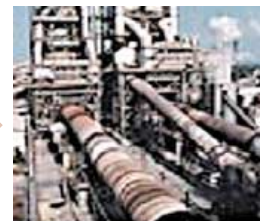
セメント製造用ロタリキルン炉 （光ファイバケーブルの全ての部材が有効活用されています。）
