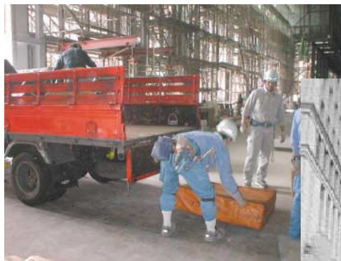
電線の共同納入状況
