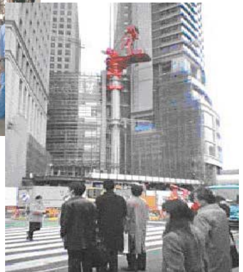
丸ノ内1丁目1街区現場状況
