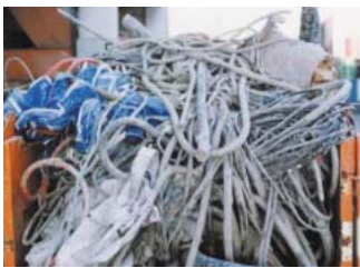
回収された使用済み電線くず （解体工事現場にて）
