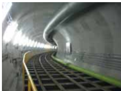
雨水貯留施設の内部状況
