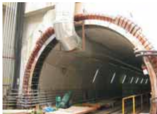
雨水貯留施設の建設状況
